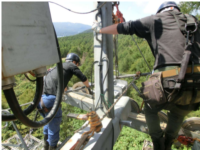
【整備画像】ゴンドラリフト支柱受索装置OH
