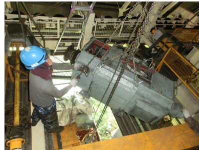
【整備画像】第3クワッドリフト主電動機OH
